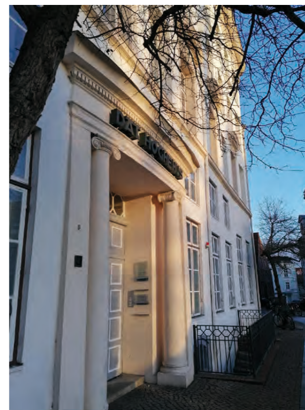
Hoghehus Fassade © DAG
